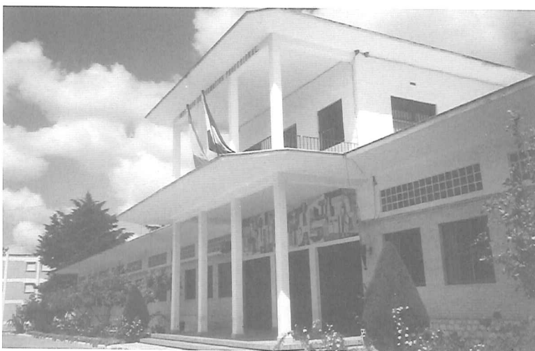
Entrada principal antes de las obras de ampliación
